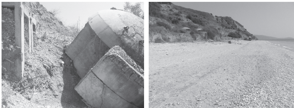
Figura 7. Dy raste të gjendjes së bunkerëve në zonën jugore të plazhit, majtas (a) një bunker i përmbysur si pasojë e erodimit të bazamentit (trasesë së rrugës) dhe (b) dy bunkerë që ndodhen në pozicionin original, por me bazament pjesërisht të eroduar. Rasti (a) ndodhet në gjysmën e largësisë nga vija aktuale bregore në krahasim me rastin (b) . Në rastin (b) dallohet qartë vendosja e depozitimeve të plazhit prej tokës drejt detit në renditjen zhavor-rërë-zhavor. Shtresa e rërës ndahet sot nga deti prej bermit aktual të vijës bregore (autori i fotove S. Marku 2015).
