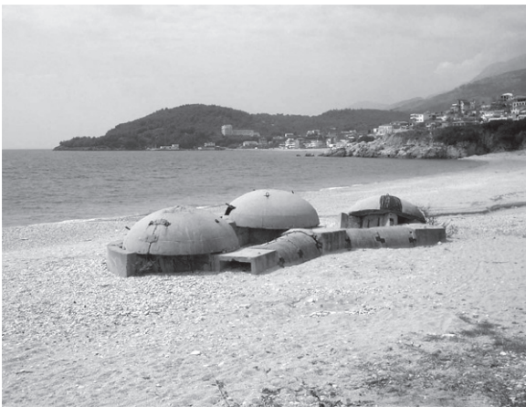
Figura 6. Pamje e bunkerëve pranë bregdetit, realizuar pas vitit 1990, ku dallohet qartë mbushja e koridorit të tyre komunikues nga zhavor dhe rërë. Lartësia e këtij koridori (sipas Stefa E., et. al. 2009) ishte rreth 1.20 metër.
