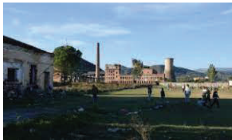
Figura 5. Rafineria e Naftës Cërrik
